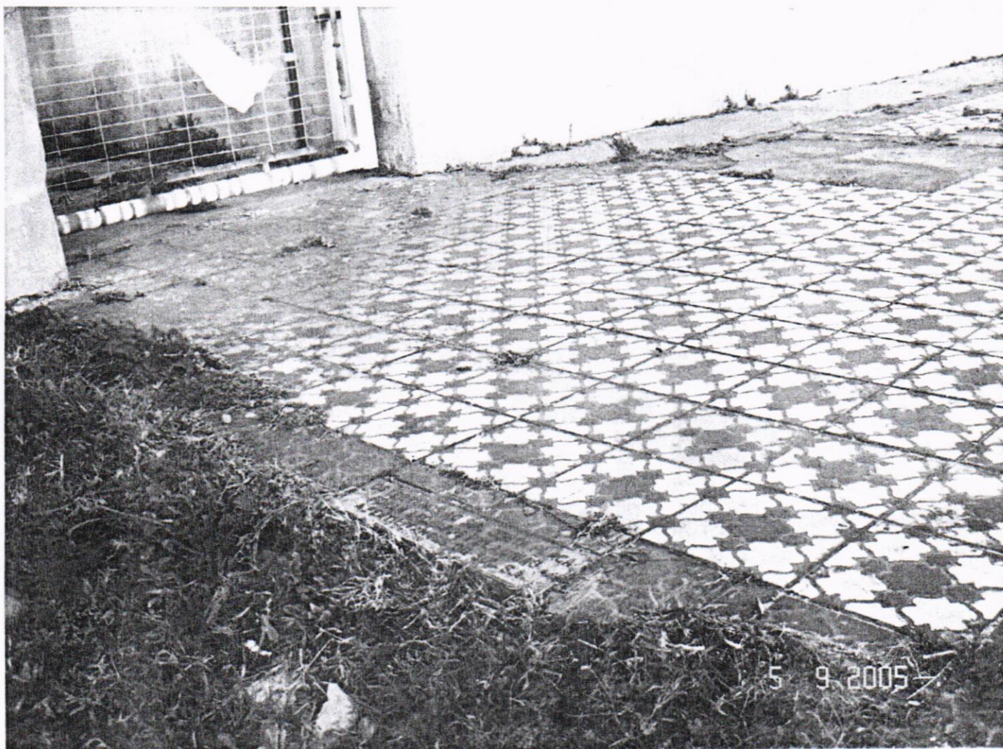
Foto 8 Avenida Honório Bicalho Detalhe da placa limítrofe na calçada do lado do recinto do porto
