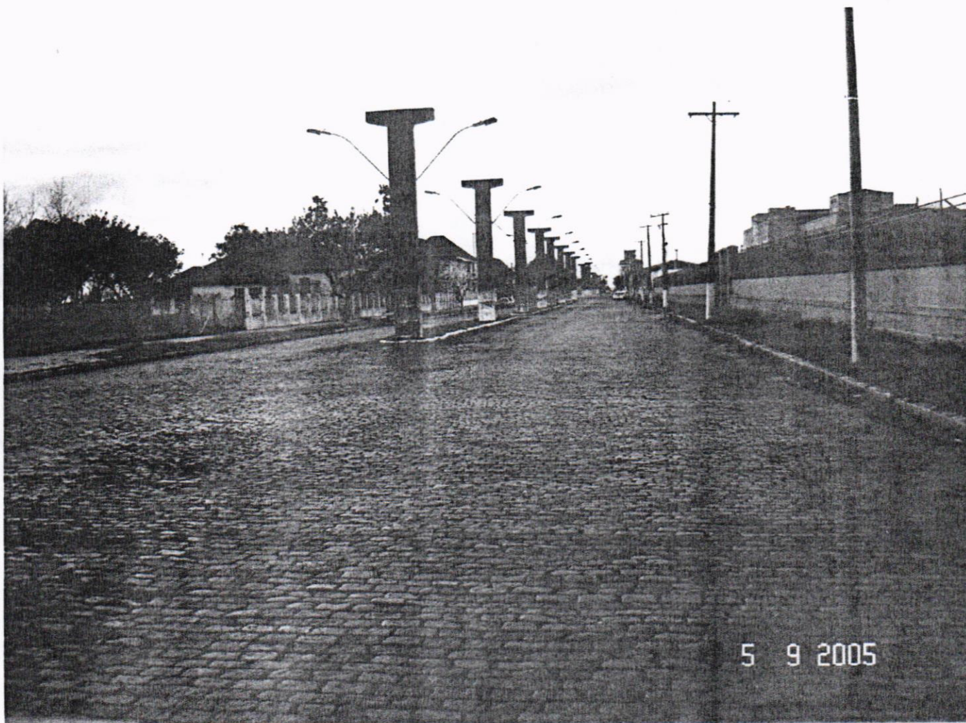
Foto 9 Avenida Honório Bicalho Detalhe da infra-estrutura
