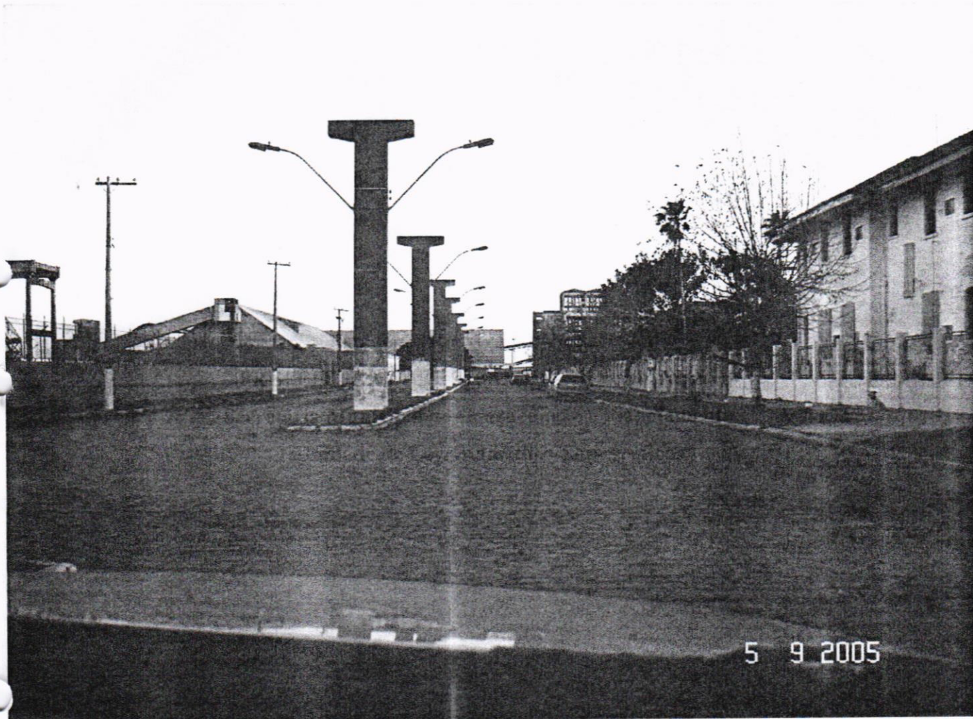
Foto 2 Avenida Honório Bicalho Detalhe da infra-estrutura
