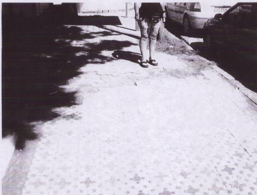
Calçada da Av. Honório Bicalho
