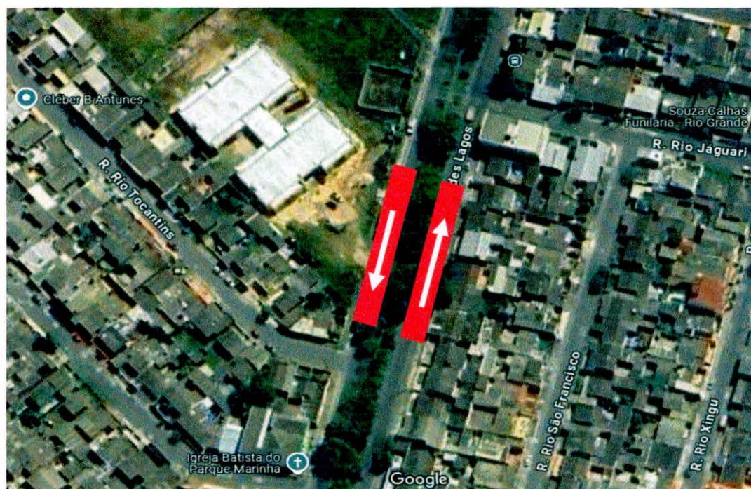
Trecho da Av. dos Grandes Lagos, Bairro Parque Marinha.
